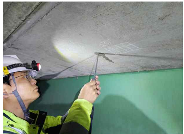
탄산화깊이 측정 현황
